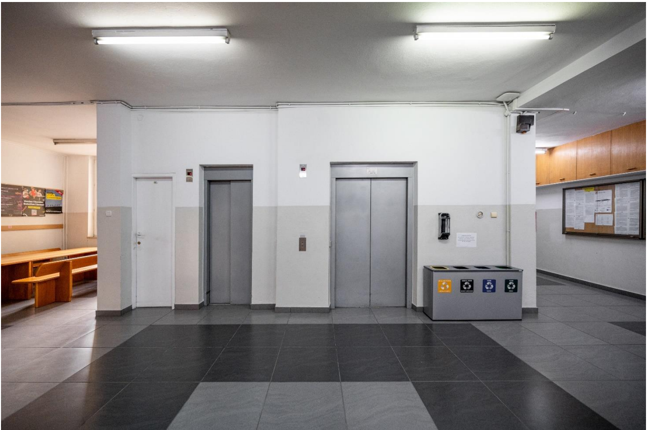
Zdjęcie 16 Widok holu windowego w budynku B.
