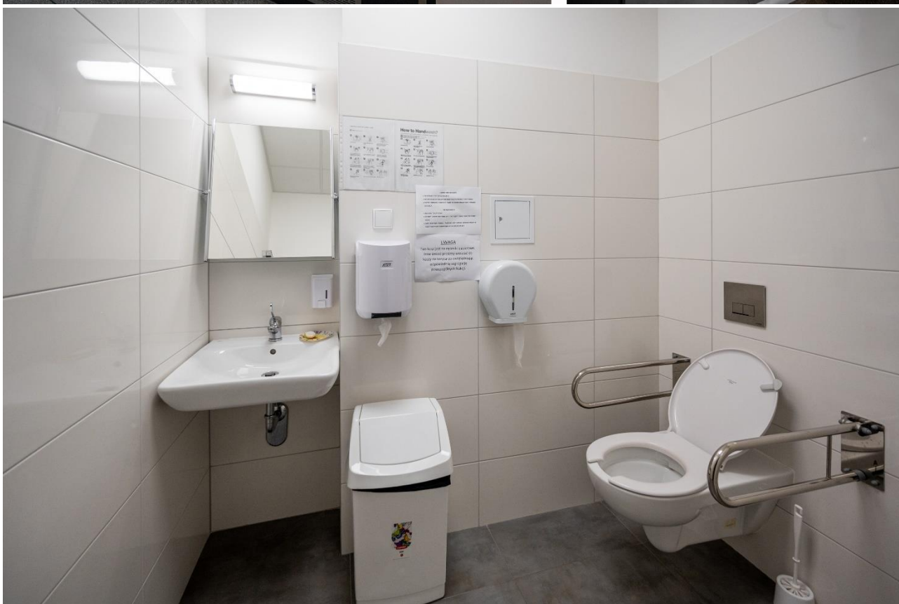
Zdjęcie 17 Widok na toaletę dostępną.
